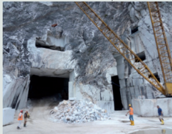
Cava sotterranea di Piastreta per l'estrazione del marmo
